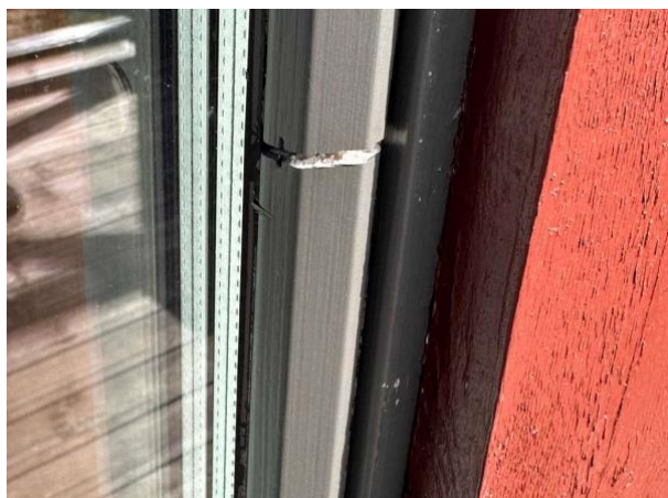
Bild 1: Utvändigt, Fönster, Dekorlisterna på en del fönster har gått isär
