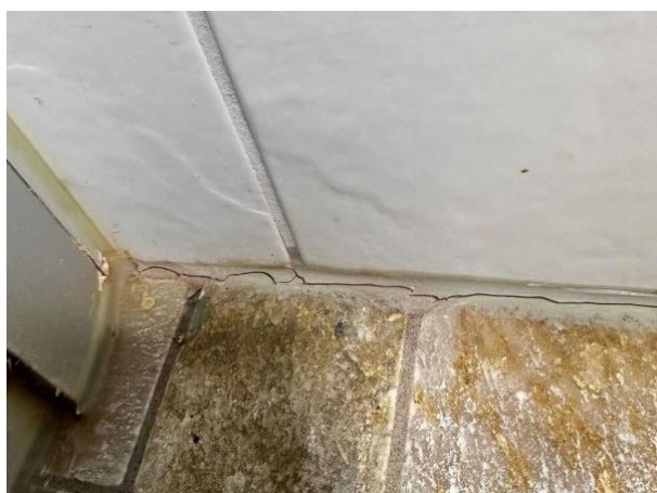
Bild 3: Invändigt, Entréplan, Spricka i mjukfog i duschen
