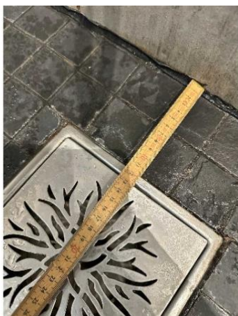
Bild 1: Invändigt, Entréplan gäst lägenhet, Golvbrunn sitter nära väggen se riskanalys
